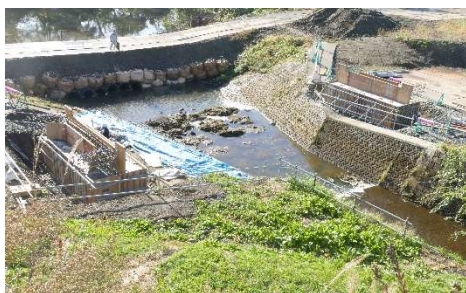
工事中の新橋（橋台が間もなくできます。）
